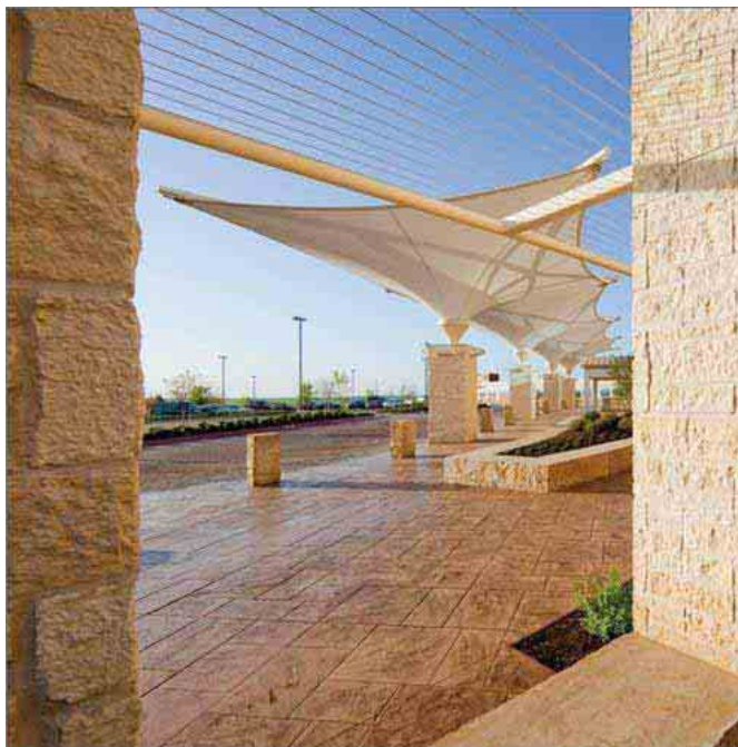
شکل ۱-۱۰-۱- استفاده از پوشش‌های غشایی در ترمینال بندر جدّه
