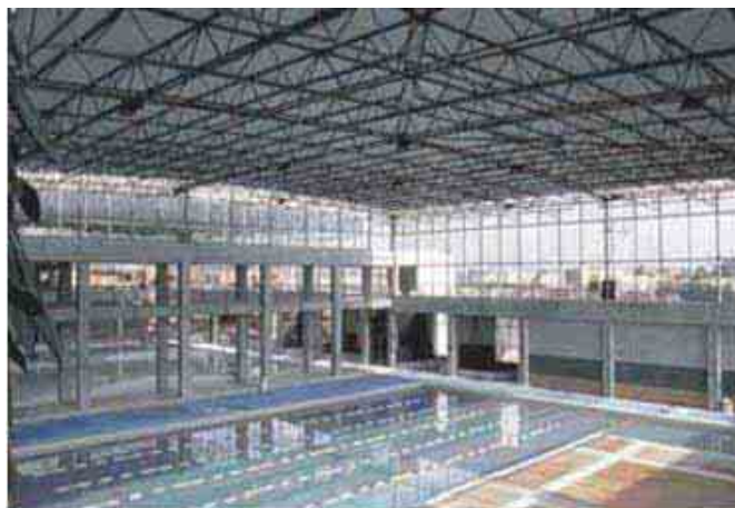
شکل ۱-۳- استفاده از سازه فضاکار آلومینیومی در پوشش دهانه استخر
