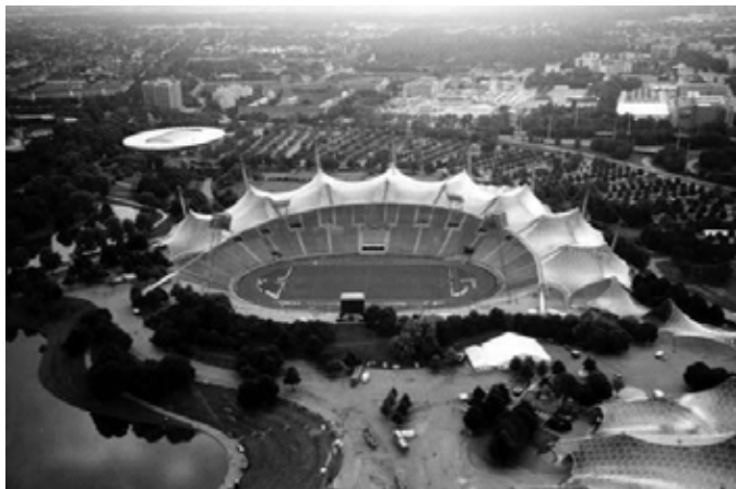
شکل ۱-۸- استفاده از سازه‌های غشایی جهت سقف استادیوم المپیک مونپخ
