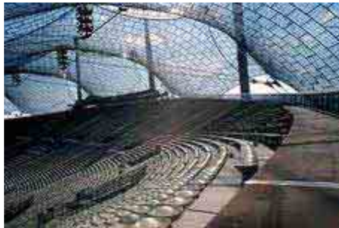
شکل ۱-۸- استفاده از سازه‌های غشایی جهت سقف استادیوم المپیک مونپخ
