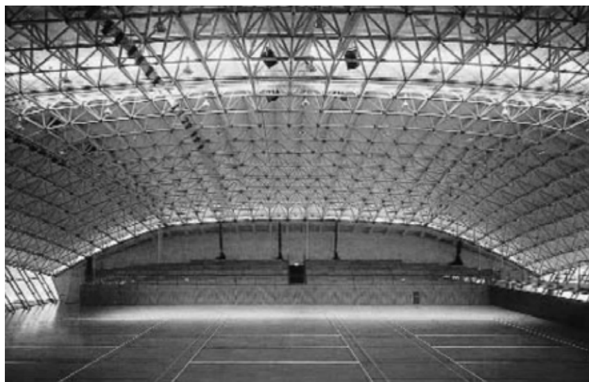
شکل ۱-۶- استفاده از سیستمهای خرپایی جهت سقف سالنهای ورزشی
