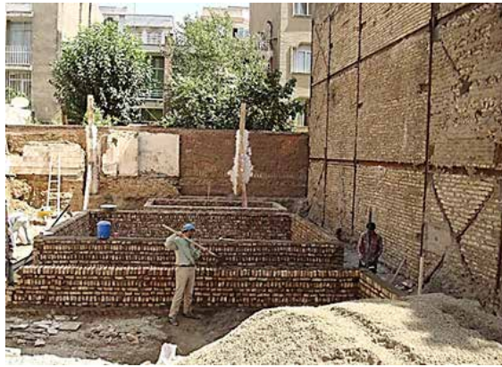
شکل ۱۱- روش متداول؛ انجام کرسی چینی قبل از اجرای بتن مگر جهت صرفه جویی در مصرف بتن مگر.
