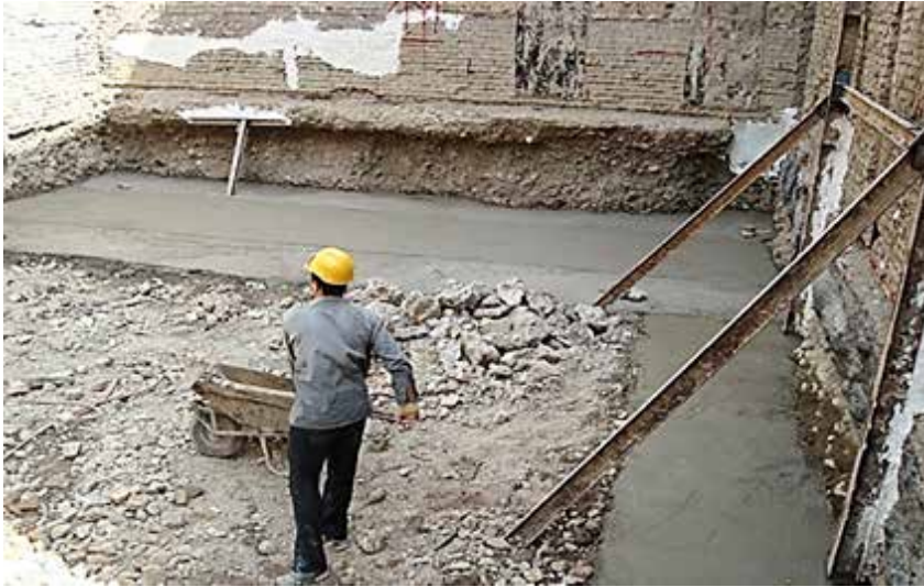
شکل ۱۲- پاکسازی گود و اجرای بتن مگر برای تمام سطح فونداسیون
