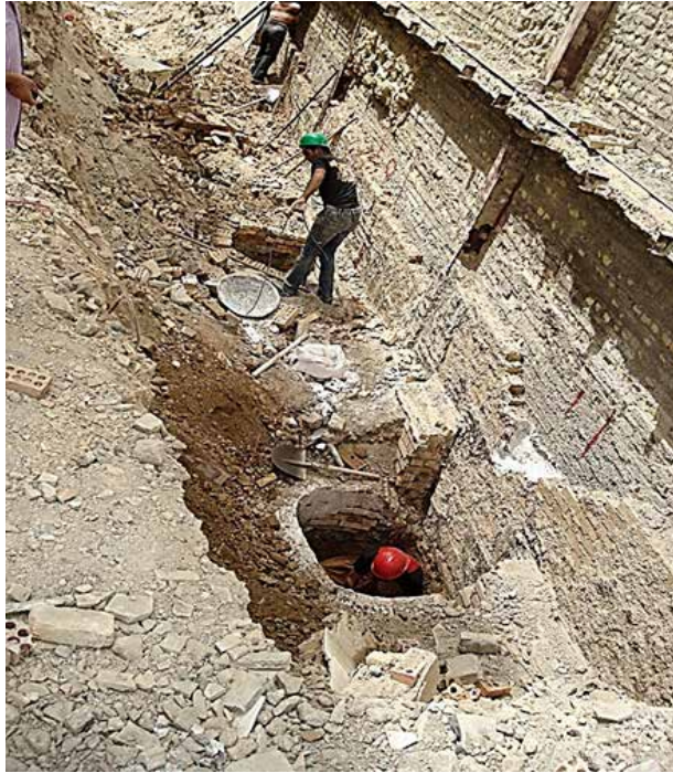
شکل ۸- در تخریب، گودبرداری و اجرای سازه‌های نگهدارنده، یکی از مهم‌ترین نکات، حفظ ایمنی است.
