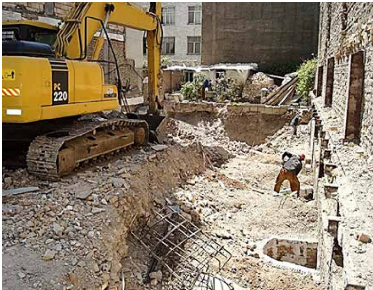
شکل ۹- اجرای چاهک‌ها و ستون‌های سازه نگهدارنده خرابی قبل از عملیات گودبرداری. البته ستون‌های موجود در شکل مربوط به سازه نگهدارنده نیست و بقایای سازه قدیمی است.
