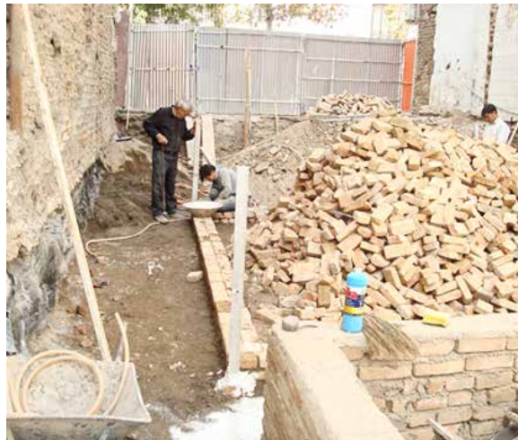
شکل ۱۲- اجرای کرسی چینی قبل از بتن مگر جهت صرفه جویی در مصرف مصالح توسط مالکین.
